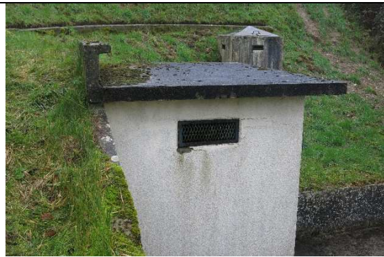
Accès au puits de captage
