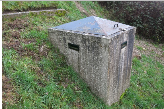
Regard d'accès sur la galerie de captage
