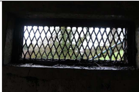
Grille à remplacer
